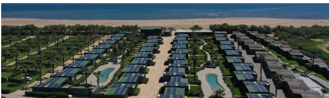
Bungalows autosuficients del Càmping Bungalow Resort & Spa La Ballena Alegre Costa Brava (Sant Pere Pescador)
